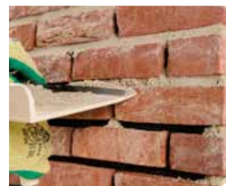
Jointoyer les plaquettes de parement
