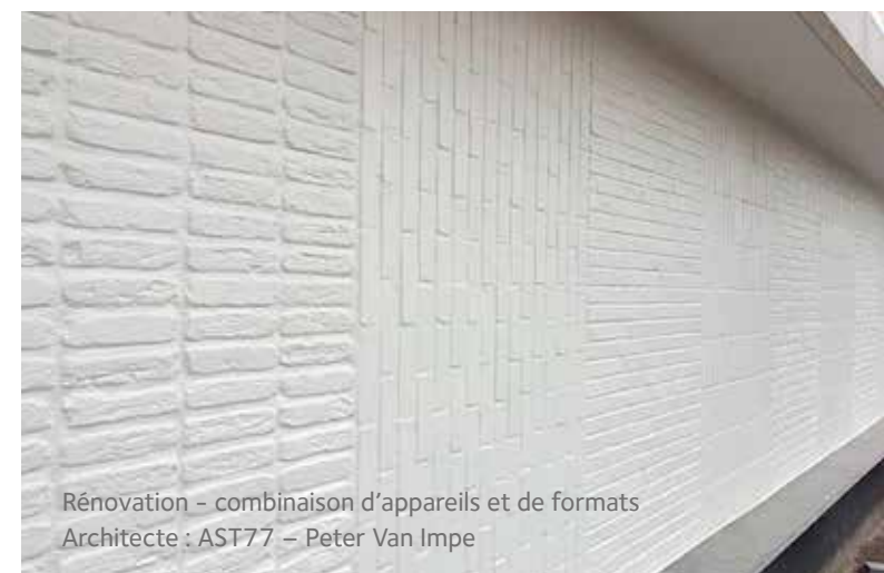
Rénovation - combinaison d'appareils et de formats Architecte : AST77 – Peter Van Impe
