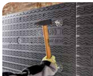
Fixer les plaques d'isolation
