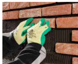
Poser les plaquettes de parement
