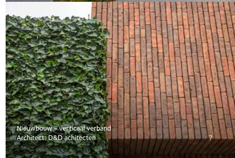
Nieuwbouw – verticaal verband Architect: D&D architecten
