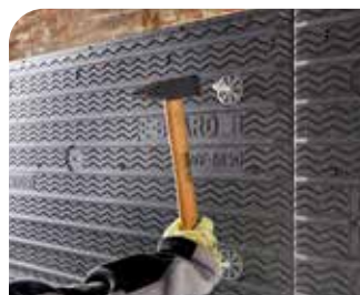
Isolatieplaat bevestigen
