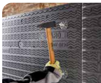
Fixer les plaques d'isolation
