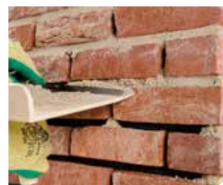
Jointoyer les plaquettes de parement
