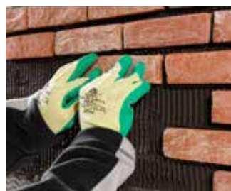
Poser les plaquettes de parement
