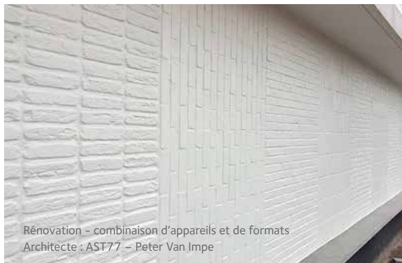
Rénovation - combinaison d'appareils et de formats Architecte : AST77 – Peter Van Impe
