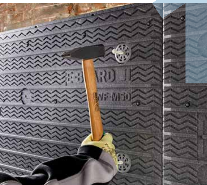
Fixation du panneau d'isolation
