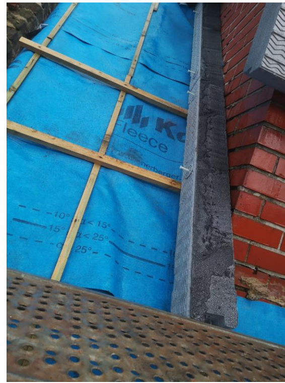
3. Isolation toit incliné
