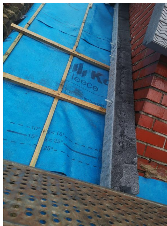
3. Isolatie aan hellend dak
